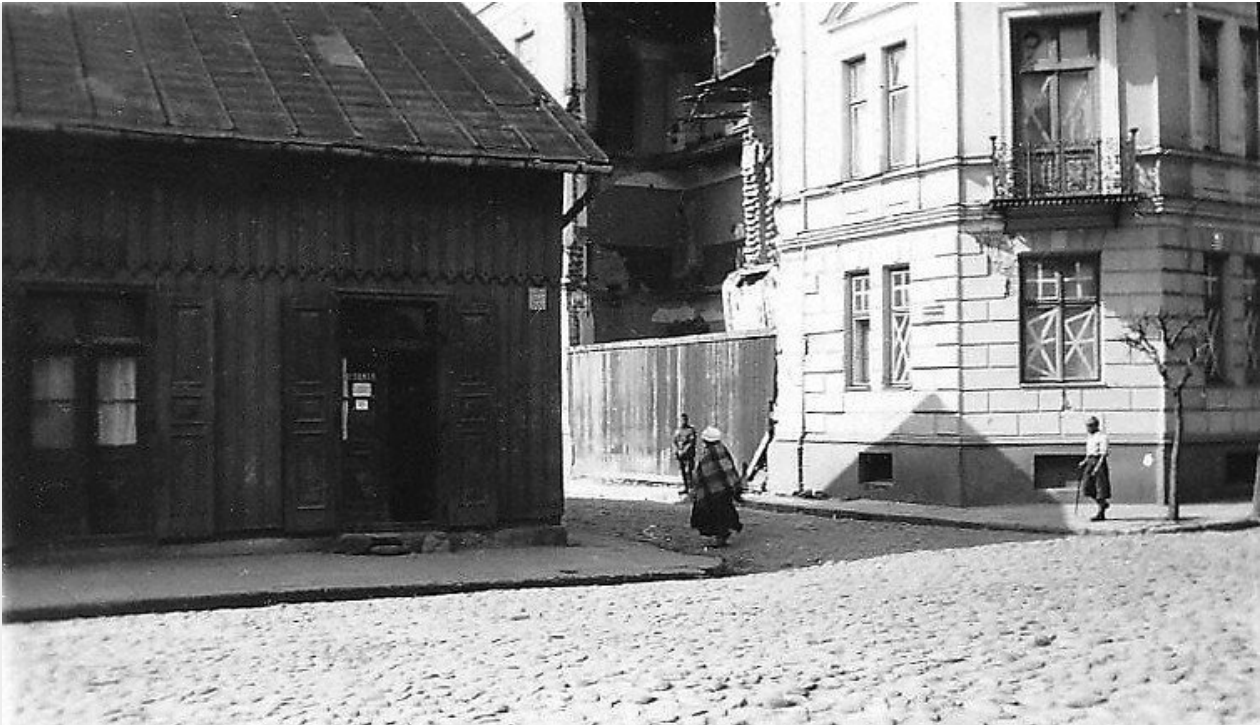
Kamienica przy ul. Jagiellońskiej 27. Podczas odbudowy i remontu usunięto wszystkie elementy architektoniczne z elewacji.
