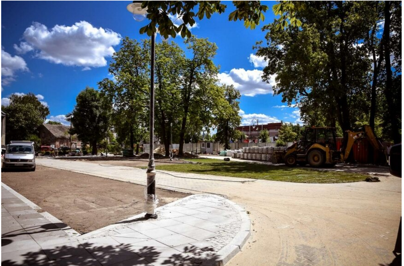
Na skwerze budowany jest parking. (Fot. Sławomir Burzyński)
