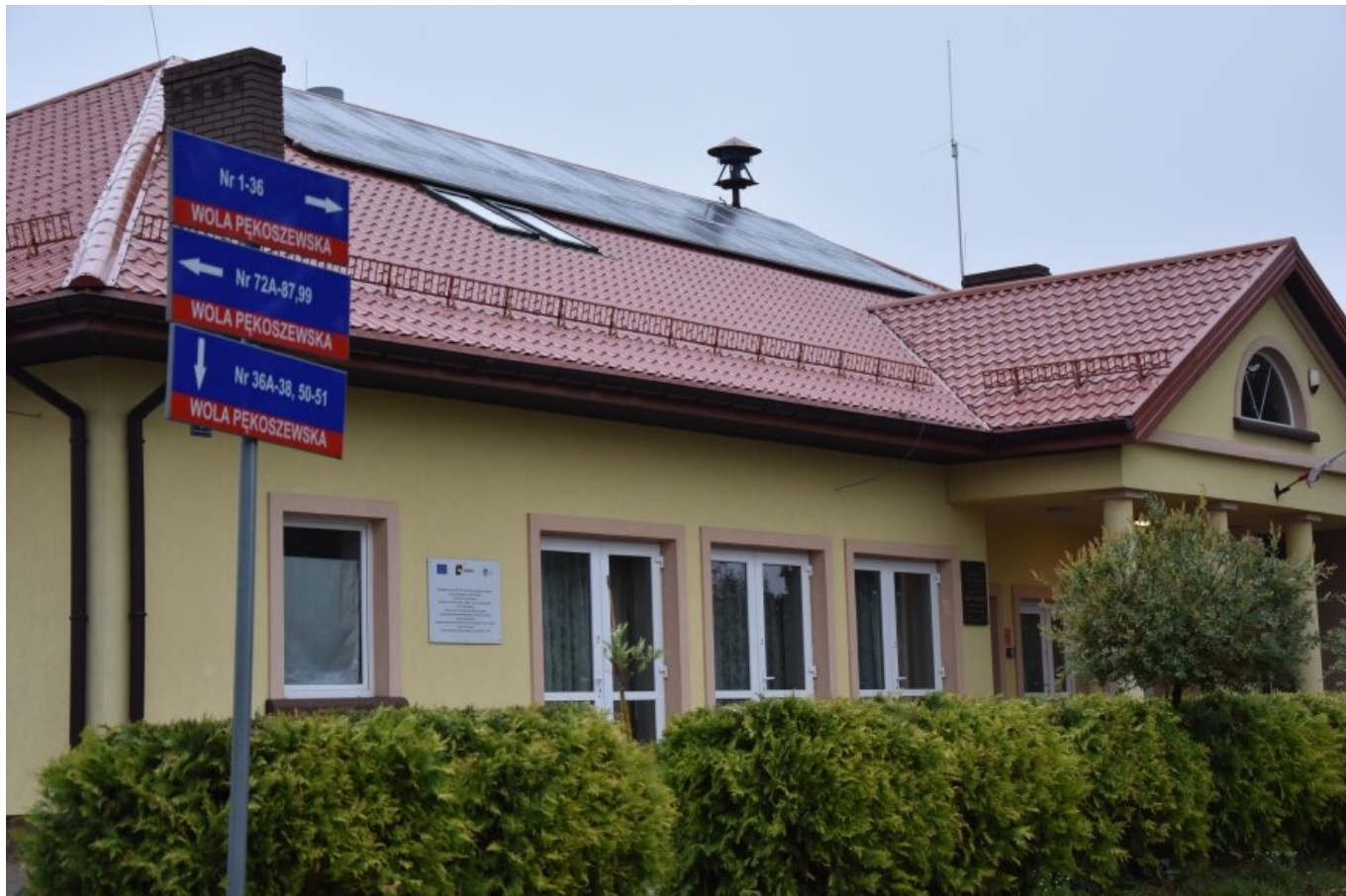
Panele już zamontowano na budynku w Woli Pękoszewskiej. (Wojciech Kubik)
