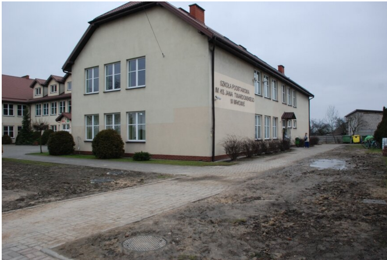
Żłobek zajmie jedno skrzydło budynku po gimnazjum. (fot. Beata Pierzchała)
