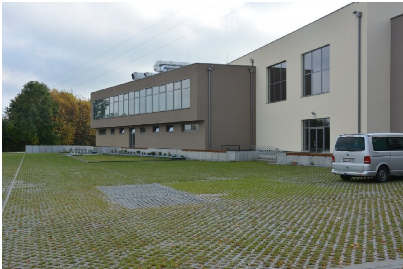
Siedzibą Makowskiego Centrum Kultury będzie nowa hala sportowa. (fot. Beata Pierzchała)
