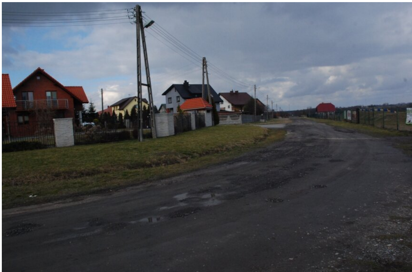
Jedną z planowanych do przebudowy dróg jest ulica Kaczeńcowa w Jezowie. (fot. Beata Pierzchała)
