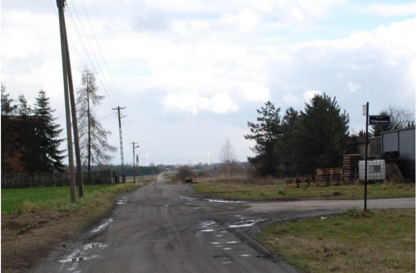
Oświetlenie uliczne jest najbardziej kosztoclonną składową gminnych rachunków za prąd. (fot. Beata Pierzchała)
