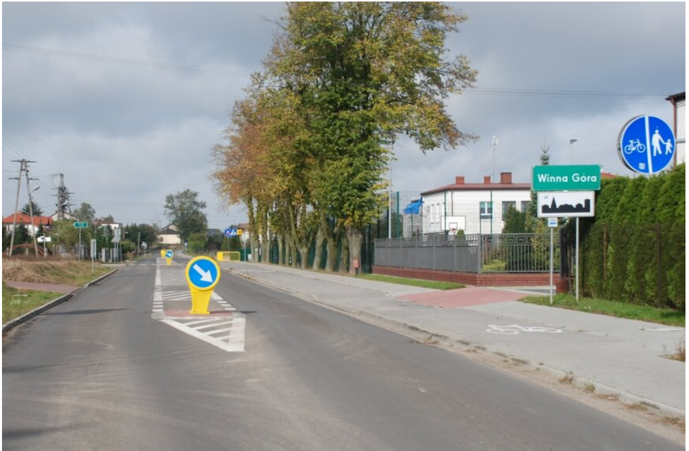
W Winnej Górze na remont czeka stacja uzdatniania wody. (fot. Beata Pierzchała)
